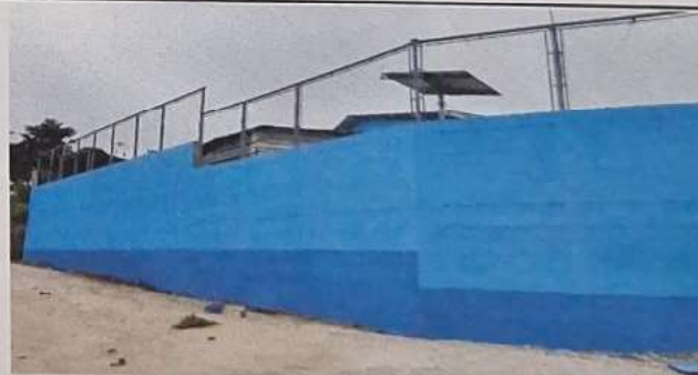
Foto 6: Pintado de muro exterior lado izquierdo
