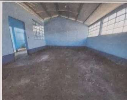
Foto 2: Sustitución de piso cerámico dentro del aula
