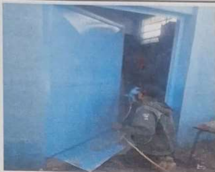
Foto 1: Pintado de puertas de aulas. 5 puertas
