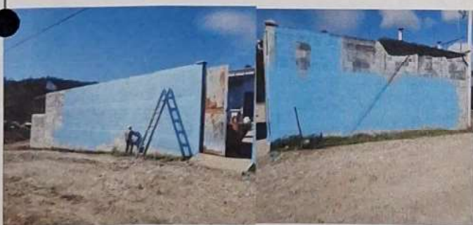
Foto 5: Pintado de muro exterior de frente
